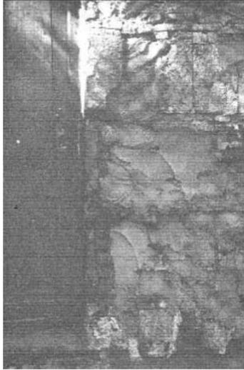
Intervención incorrecta: sustitución de los ladrillos de protección del muro de adobe por un azotado de cemento. Casa de Sor Josefa Diaz y Clucellas (Santa Fe)
