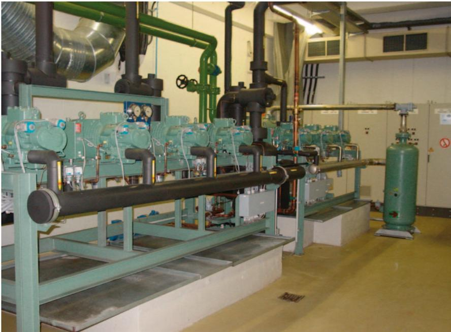
**Abb. 11.3** Schraubenverdichter zur „Kälteerzeugung“ im Maschinenraum. (Quelle: Imtech Deutschland GmbH & Co. KG)
